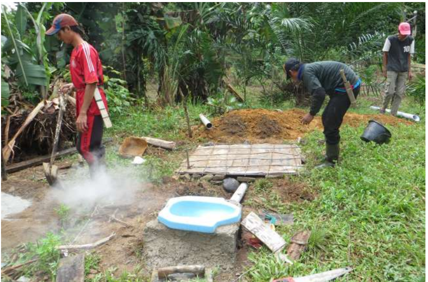
Penyambungan saluran pembuangan dari wc ke septik tank (Dokumentasi WVI AP Bengkayang)
