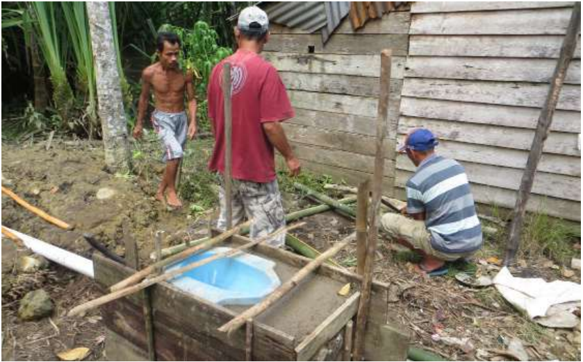
Pembuatan toilet dan septik tank di salah satu dusun dampingan (Dokumentasi WVI AP Bengkayang)
